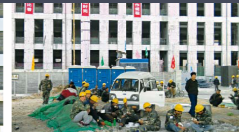
Mittagspause auf der Baustelle.
